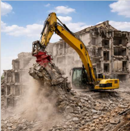
Demolición de Edificaciones y Estructuras Verticales y Horizontales
