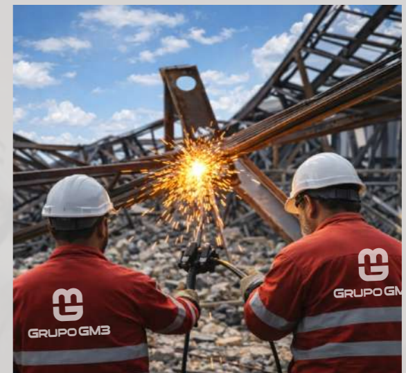
Desmontaje de Estructuras Metálicas y otros.
