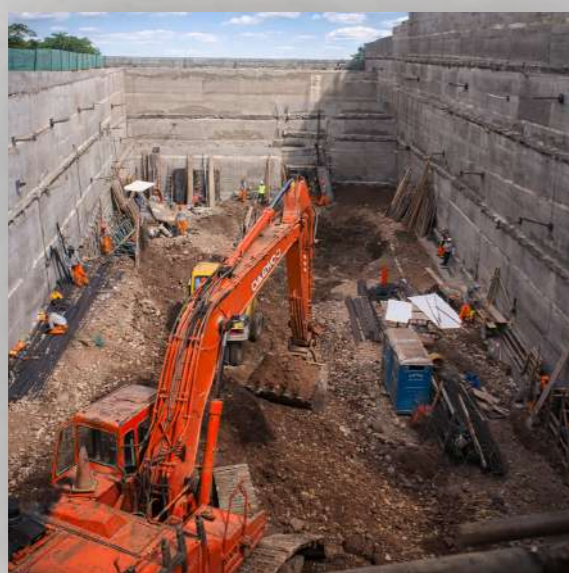
Excavaciones Masivas y Localizadas
