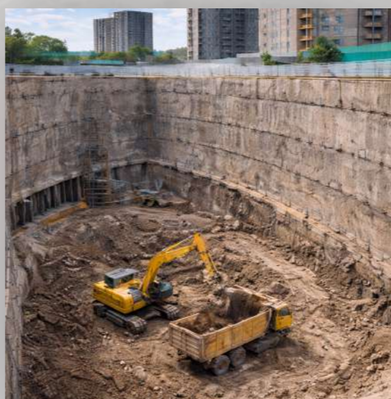
Excavaciones de sótanos profundos
