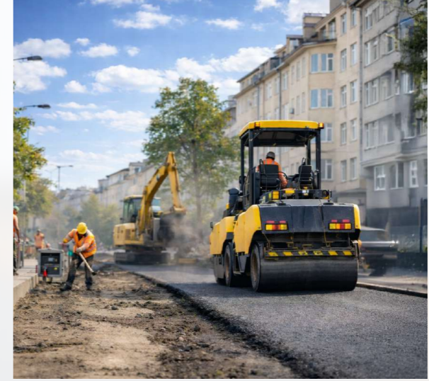
Vías Urbanas Construcción y Rehabilitación de Pistas y Veredas.
