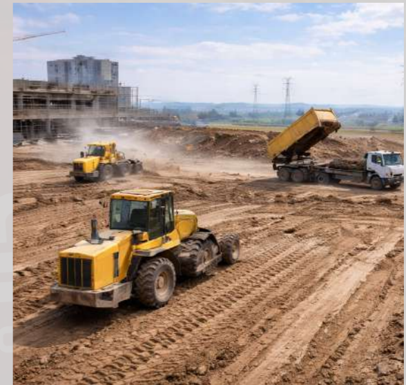
Rellenos controlados y Plataformados
